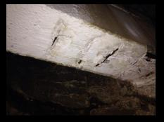
Eliminação de infiltração e recomposição de emboço e pintura.
